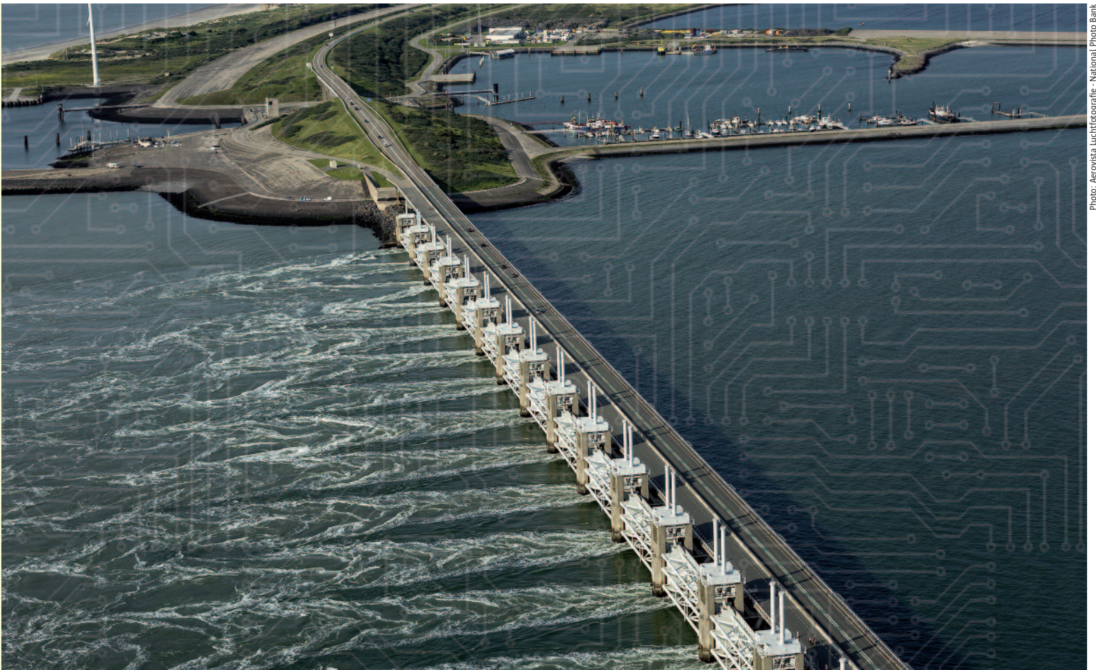
Photo: Aerovista Luchtfotografie - National Photo Bank
